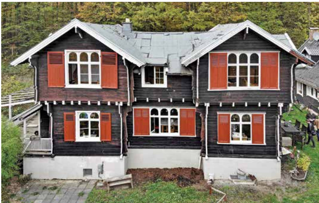
8 Das ehemalige Forst- und Jagdhaus eines Kölner Unternehmers wurde im Jahr 1905 bei Rieferath in der Gemeinde Windeck aus vorgefertigten Bauteilen errichtet. Der Blockbau stammt aus dem Programm des Sägewerksbesitzers Wilhelm Witte aus Osterwieck/Harz. (Foto: Michael Kamp, 2018)
