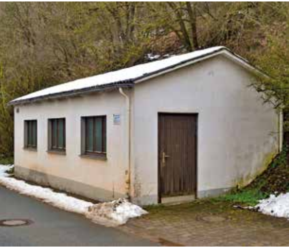
1 Der Zweckbau für die Gemeinschaftsgefrieranlage (Warmraumgefrieranlage) aus Medebach-Dreislar, 2018 (Foto: Frederik Grundmeier, LVR-Freilichtmuseum Lindlar)
