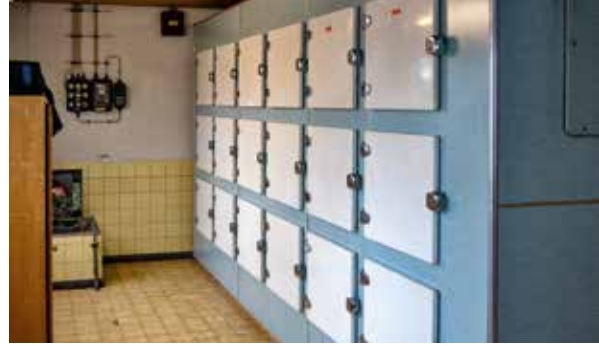
3 Die Warmraumgefrieranlage aus Medebach-Dreislar vor dem Abbau, 2018 (Foto: Frederik Grundmeier, LVR-Freilichtmuseum Lindlar)
