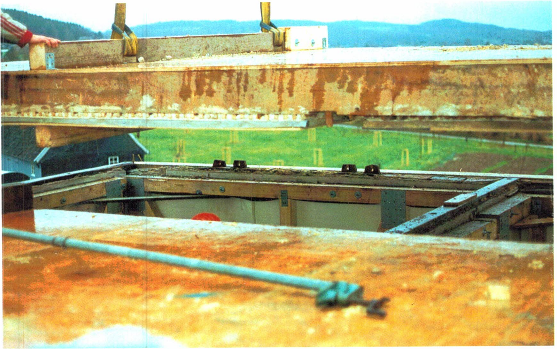
Das letzte Deckenteil schwebt ein: Wände, Zapfenverbindungen und Holznägel müssen in Millimeterarbeit wieder zusammengefügt werden
