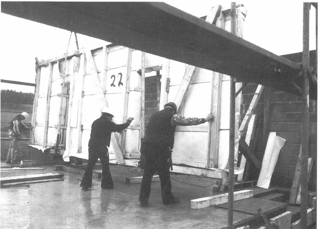
Größte Genauigkeit war beim Aufsetzen der ersten Wände des Erdgeschosses gefragt
