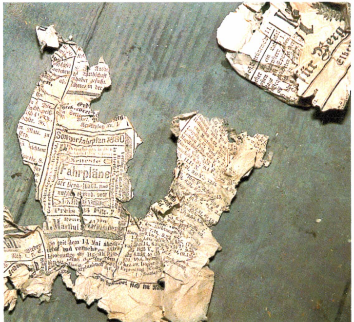
Hier eine gute Überraschung: diese Zeitung aus dem Jahr 1880 war im Dach zwischen die Fußbodendielen eingebaut
