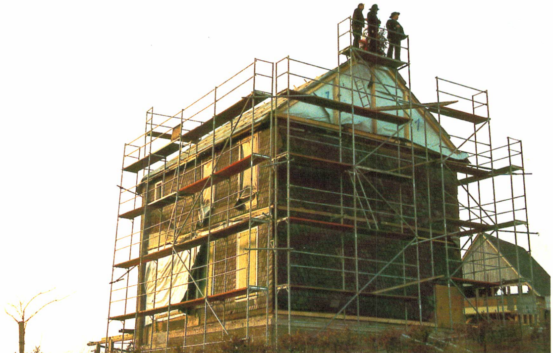
Richtfest: Endlich unter Dach!
